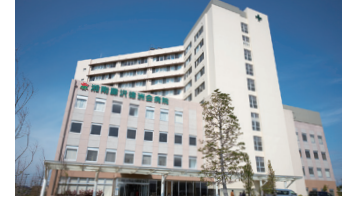
地下1階、地上10階の免震構造です。
