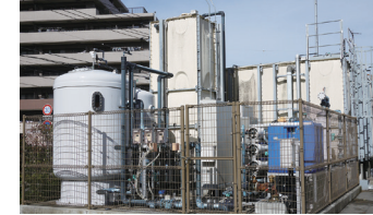
水は地下水と県営水道の二重の供給源があります。
